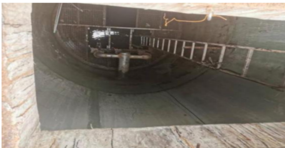
图3 事故泵站水泵吊孔俯视图
